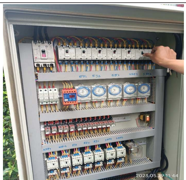
รูปที่ 2.6-5 ตู้ควบคุมระบบบำบัดน้ำเสีย
